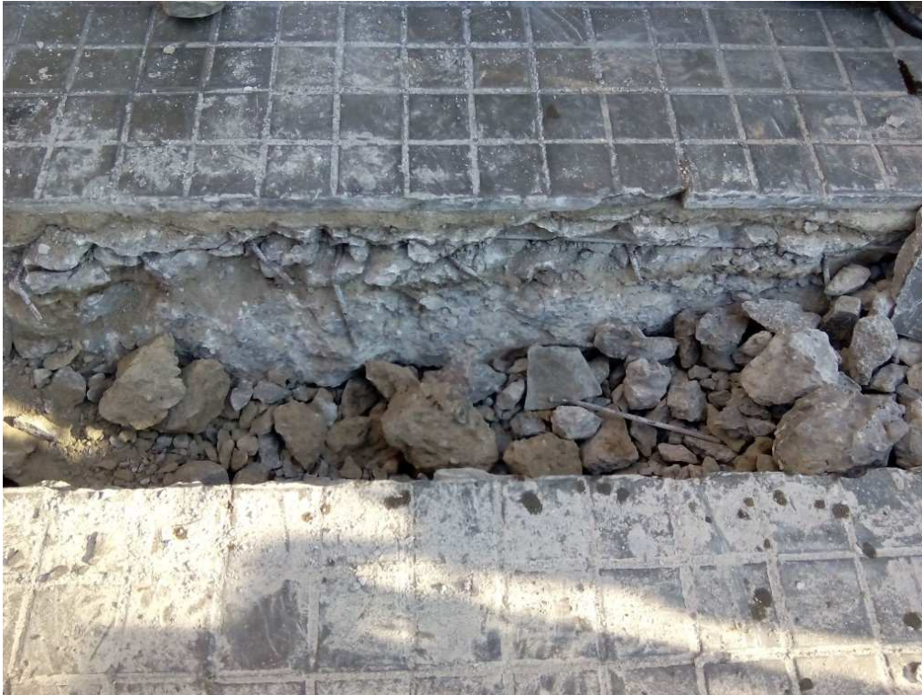
Detall del tram de rasa excavat a la Plaça de Catalunya, afectant únicament anivellacions contemporànies de formigo.
