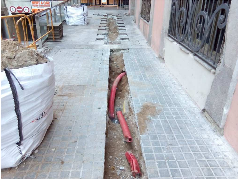
Detall d'un tram de rasa on apareixien serveis preexistents.
