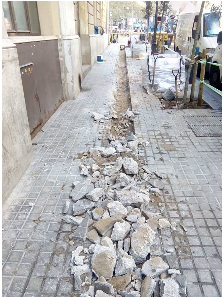
Vista general de la rasa excavada al carrer Rivadeneyra.
