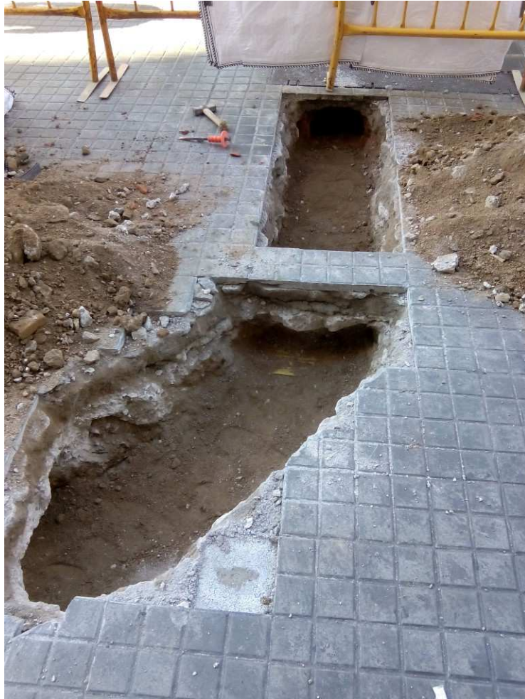
Detall del tram final de la rasa. Sota el reblliment de sauló es poden veure les proteccions del serveis elèctrics preexistents.
