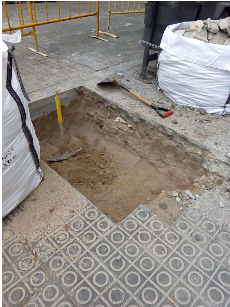
Vista de la arqueta excavada a la confluència del carrer Rivadeneyra i la Plaça Catalunya.
